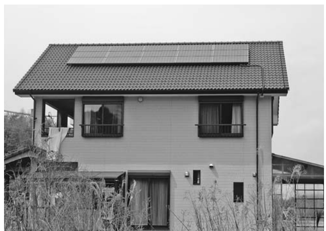
自宅の屋根に設置された家庭用太陽光発電設備
