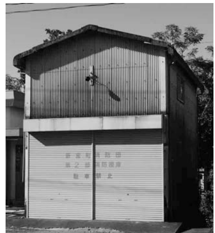
建設から長年経ち老朽化が著しく替えが待たれる消防機庫
