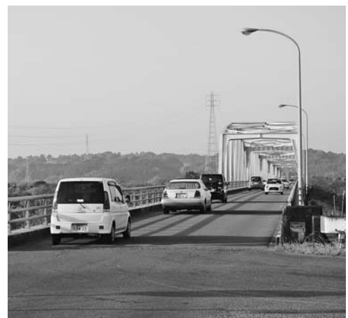
歩行者が危ないツ瀬橋
