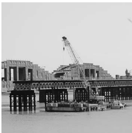
建設と改修が同時進行中の新旧日向大橋
