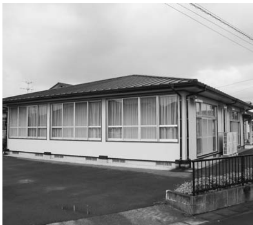
町内の地区集会所に太陽光発電を設置予定
